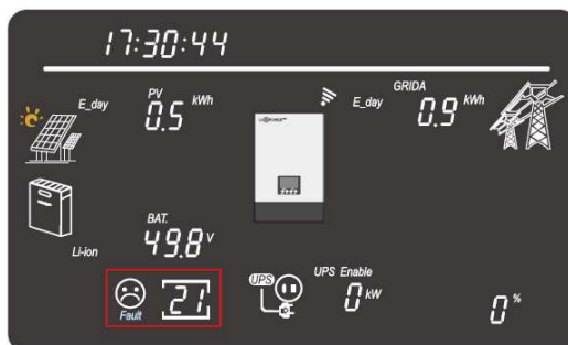
Estado de falla, falla 21
